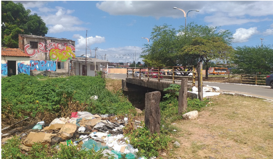
Fig. 18 - Canal do Portinho, vendo-se vegetação e entulho de construção.
