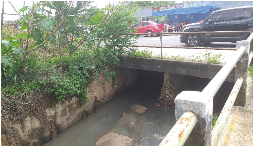
Fig. 15 – Canal do Renascença, vendo-se o assoreamento que reduz a seção.
