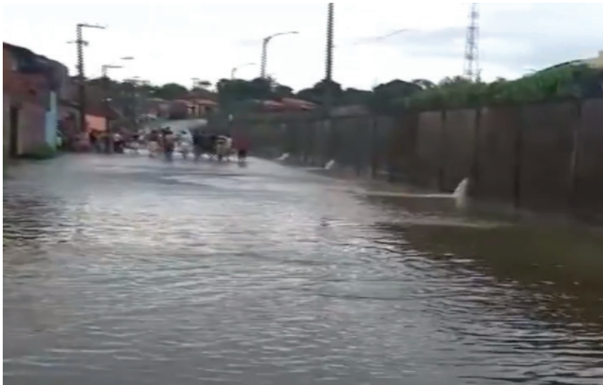
Fig. 9 – Inundação decorrente do Canal do Rio das Bicas, em março de 2009.
